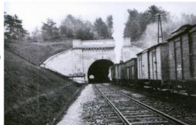
Aukštųjų Panerių geležinkelio tunelis
