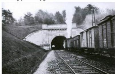
Aukštųjų Panerių geležinkelio tunelis
