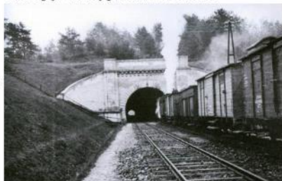
Aukštųjų Panerių geležinkelio tunelis
